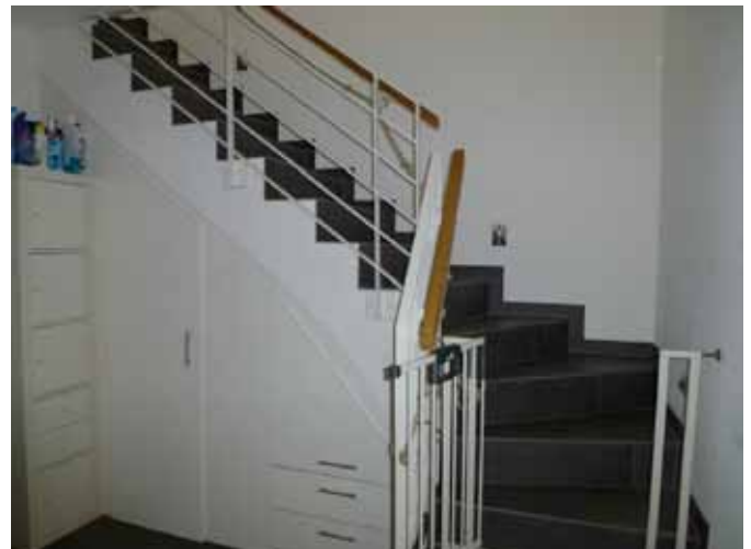
Treppe - 2. in 3.OG (Dachgeschoss) + Einbauschränk
