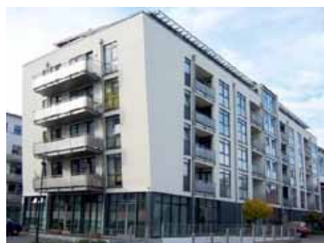
Aussenansicht- Zufahrt + TG-Zufahrt - NO
